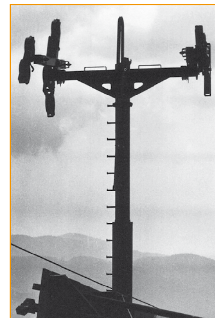
Podpera č. 34 po osadení
