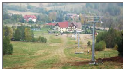
Kamienica – realizácia stavby
