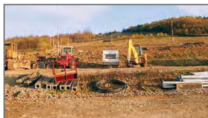
Harbutowice – realizácia stavby
