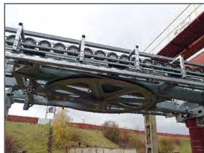
Les Menuires – realizácia stavby
