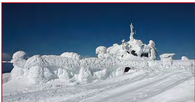
Budova vrcholovej stanice lanovky Kosodrevina – Chopok (február 2009)
