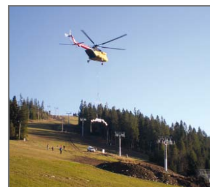
Montáž traťových podpier
