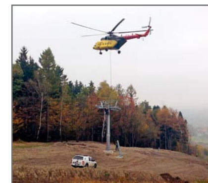
Montáž trate lanovej dráhy
